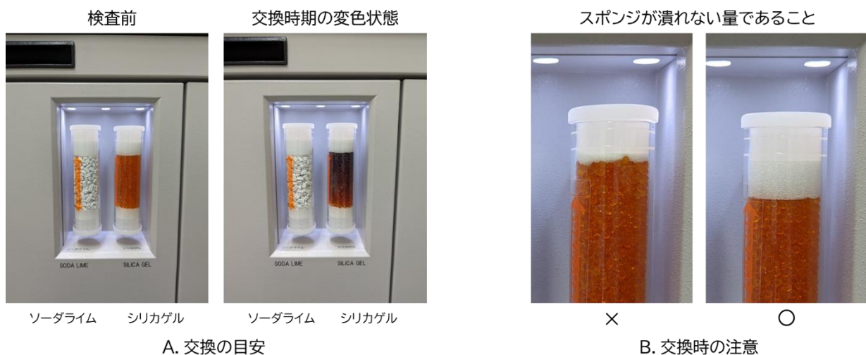
図 II-9 シリカゲル・ソーダライムの交換
