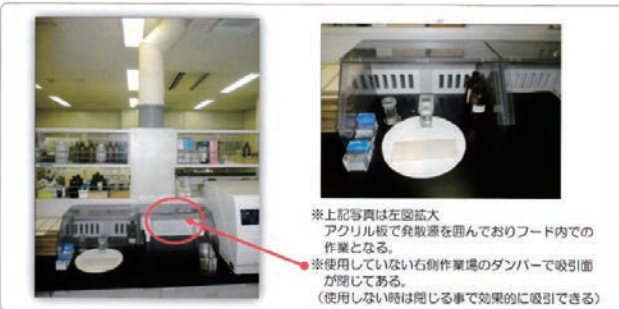
図13 外付け式換気装置使用下での作業風景
