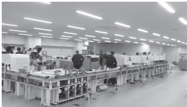
機器搬入・整備中の検体検査室
